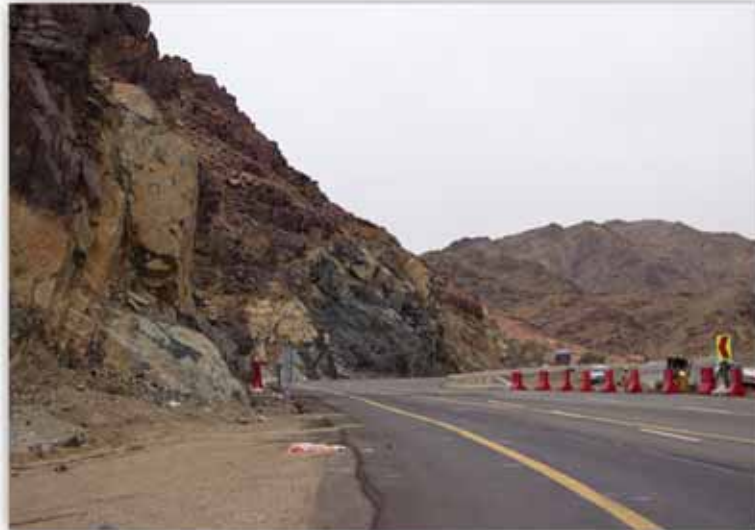
صورة توضح تساقط الصخور والإنهيارات التي قد تلحق بالطريق من أثر ميل القطع الصخري باتجاه الطريق
