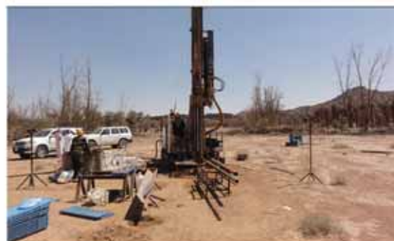
صورة توضح عملية الحفر
