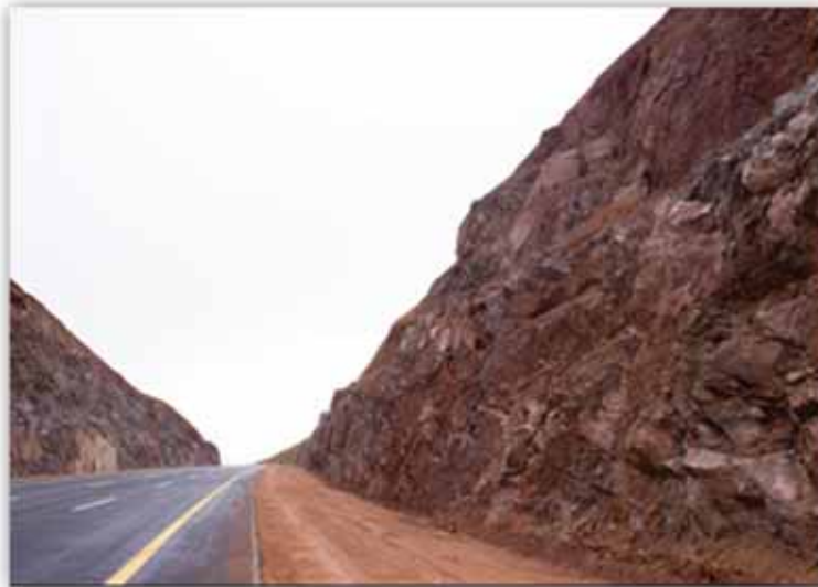
صوره عامة توضح جزء من عقبة الخريطة طريق تبوك - ضباء
