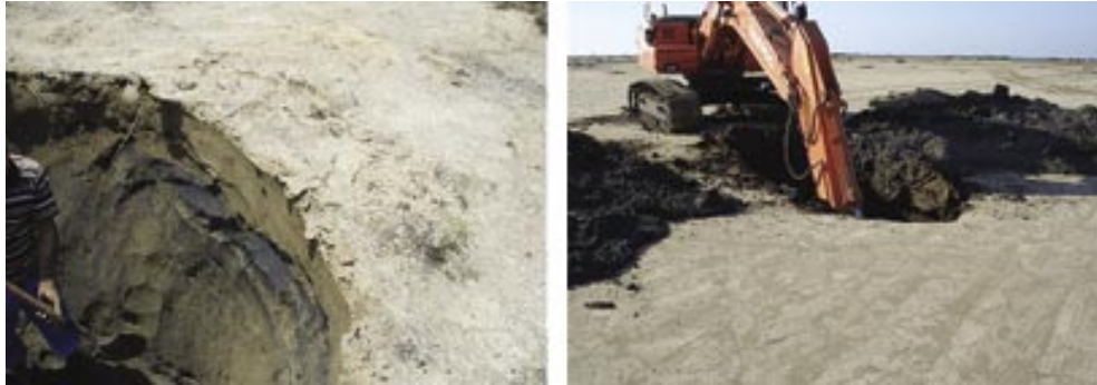
شكل (٤٥): طرق الحفر في السبخ وظهور ركيزة معدنية من الرمال السوداء في الطبقات تحت سطحية
