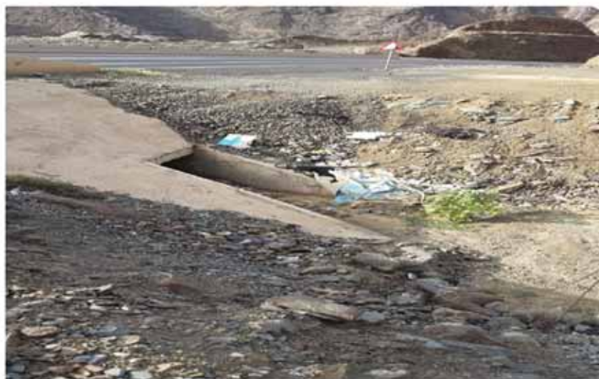
صورة توضح العبارات التي تحتاج صيانة
