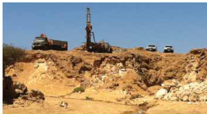
صورة توضح أعمال الحفر بمنكشف وادي العرجاء.
