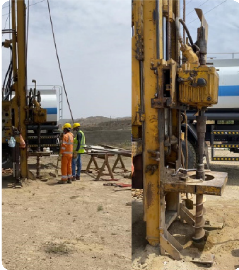
صورة توضح معدات الحفر في منطقة الدراسة
