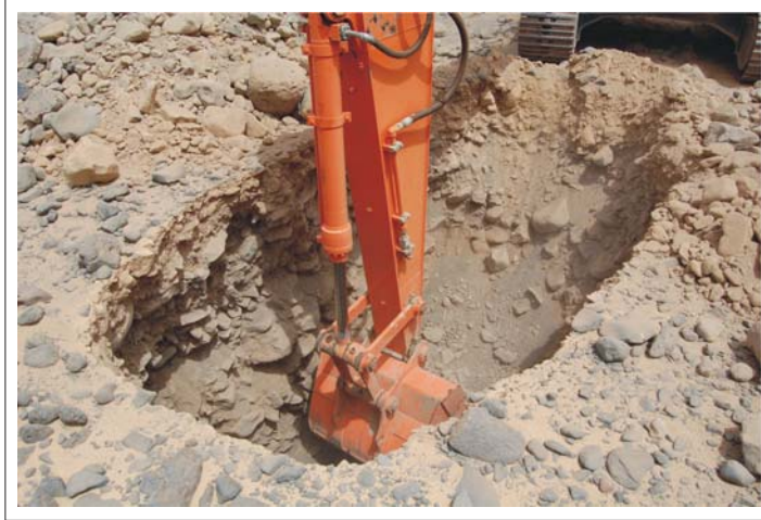
شكل (٦٧): أعمال الحفر بوادي ورجان
