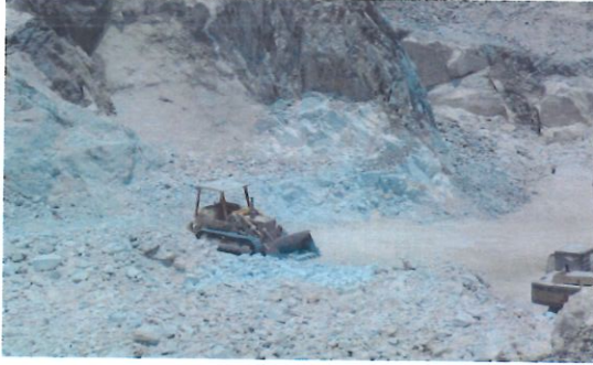
شكل ٤٩: رخام بئر ابن حصاني منطقة عسير:
