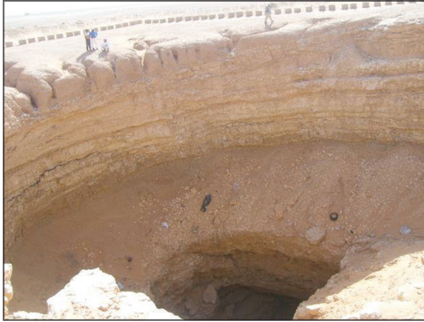
شكل (٥): صورة توضح فتحة رأسية إنهيارية (بالوعة sinkhole) ضخمة في متكوني العرمة، وأم رضة في منطقة الخفيسات، جنوب شرق بلدة الأرطاوية بمحافظة المجمعة.
